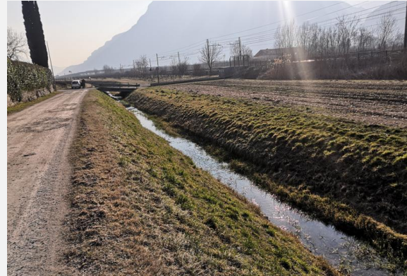
Rio Scanupia in affiancamento alla linea storica
