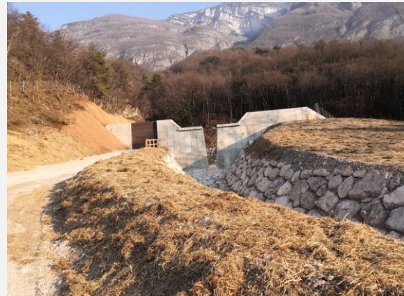
Interventi di recente realizzazione tratto conoidale Rio Scanupia
