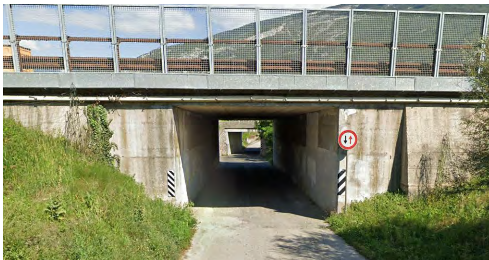
Figura 20-10 - Sottopasso autostradale e ferroviario di Via vecchio Alveo (2)
