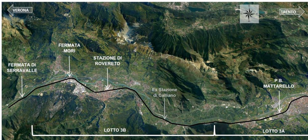
Figura 5-1 – Inquadramento su foto aerea della linea esistente su cui ricade l'intervento del Lotto 3
