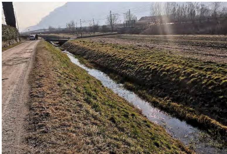
Figura 7-11 - Fosso in gestione del Consorzio Trentino di Bonifica in affiancamento alla linea ferroviaria
