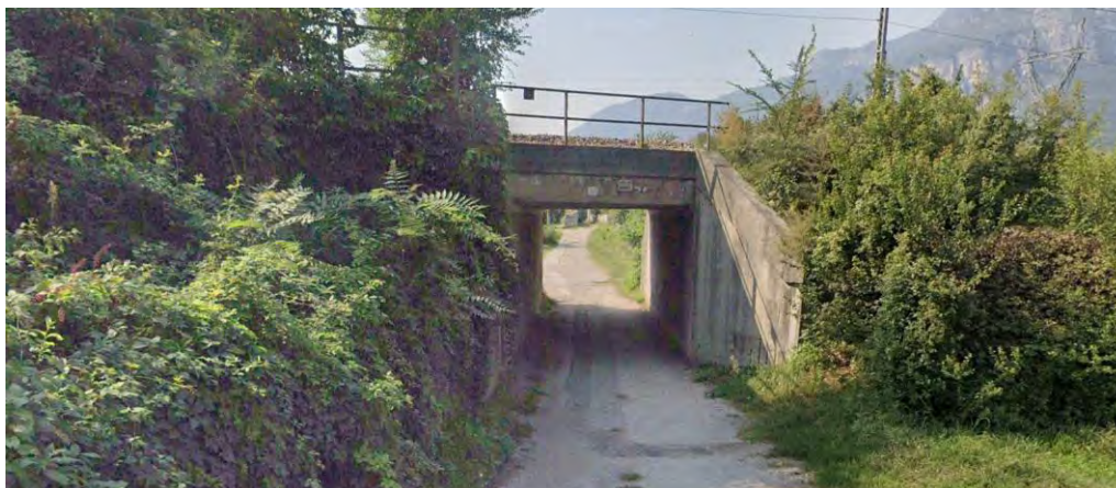
Figura 20-13 - Sottopasso esistente Via Stazione
